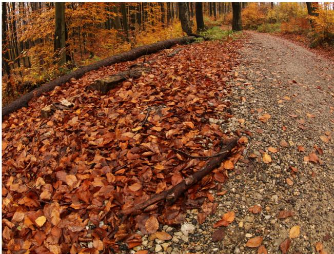
*Die Zerschneidungswirkung von Forststraßen kann durch geringe Fahrbahnbreite, geländeangepasste Bauweise, geschlossene Überschildung sowie durch viel Totholz und Bodenstreu in Straßennähe verringert werden.*
